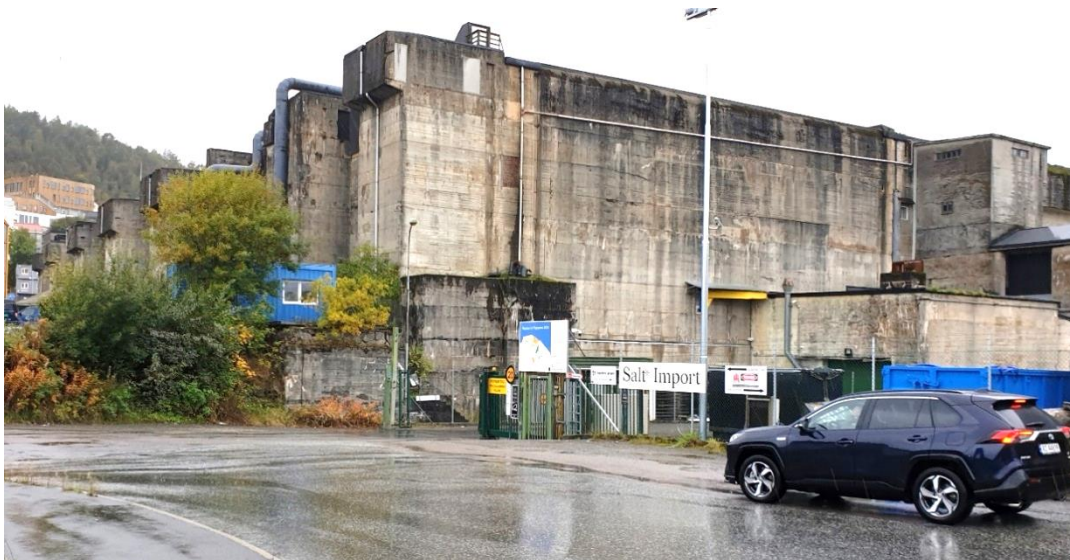
Ubåtbunkeren på Laksevåg i dag.
